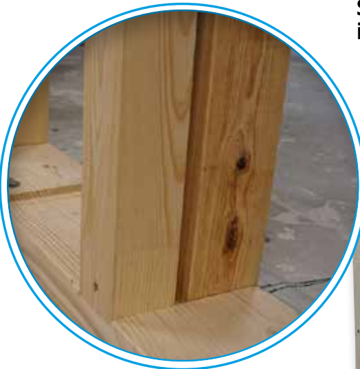
Geteilter Holzständer mit durchgängigem Rähm und Schwelle
