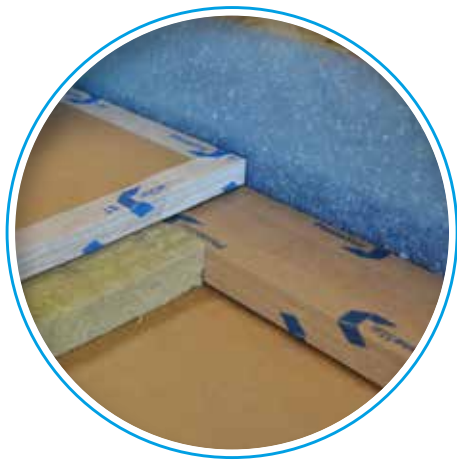
Prüfraum mit PhoneStar Schalli am Boden - randumlaufend
