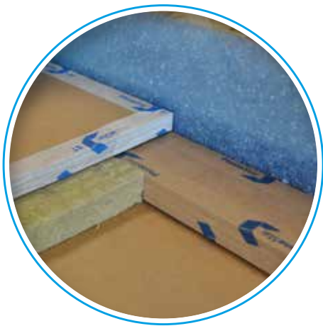
Testrum med PhoneStar Schalli på golvet - runtgående
