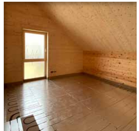
Schnelle Heizreaktion überzeugend im Neubau
