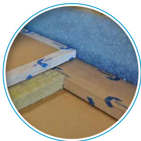
Salle d'essai avec PhoneStar Schalli au sol - sur le pourtour
