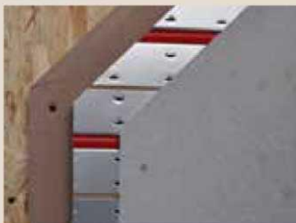
Montaż na ścianie
