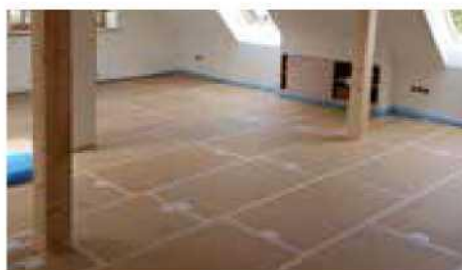
Przebudowa poddasza PhoneStar ułożone tak, by tworzyły jedną warstwę
