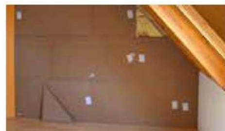
Izolacja ściany PhoneStar ST
