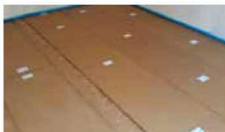
Konstrukcja modułowa - PhoneStar skleje tak, by tworzyły kilka warstw
