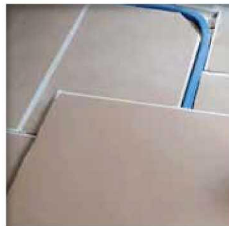
PhoneStar 25 - jako kompensacja poziomu / regulacja wysokości
