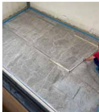
EINBRINGEN DER SCHÜTTUNG
