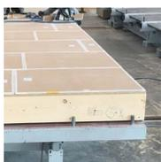
**Bodenaufbau - gemessen nach ISO 140 -  $R'_w = 68$  dB /  $L'_{n,w} = 48$  dB**
