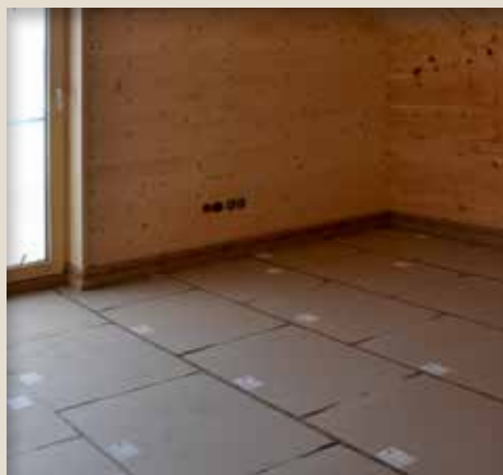
PhoneStar 25 Zavorramento del solaio
