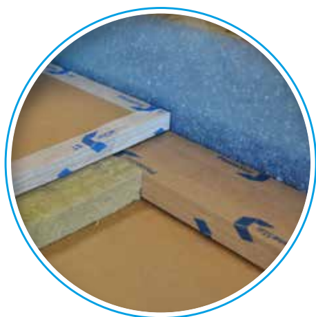
Sala prove con PhoneStar Schalli sul pavimento - perimetrale
