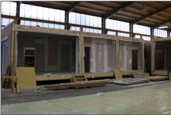
Smarthouse-Module in der Fertigung
