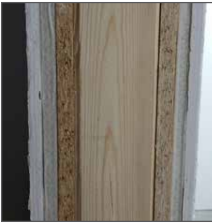
Modul-Wand Querschnitt
