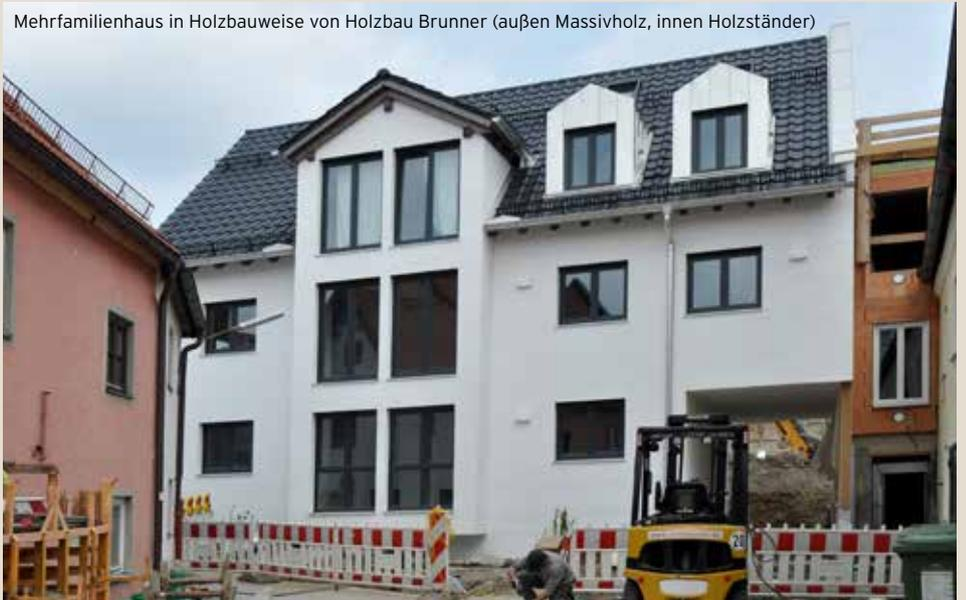
$L'_{n,w}$  von 44(1) dB. Auch der Luftschall mit  $R'_{w}$  erreichte mit 60(-3/-6) dB hervorragende Werte.
